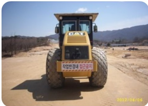
기초 다짐 작업
