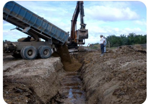
연약 지반 보강 작업
