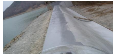
5. 고인성 항균성 모르타르 도포 완료 후
