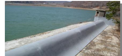
6. 세라믹 도장재 도포 완료 후(공사완료)
