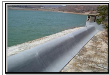
수리시설물 보수, 보강 후 전경
