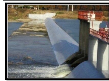
수리시설물 보수, 보강 후 전경
