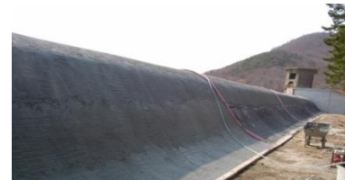
3. ㄴ자형 유리섬유봉 시공
