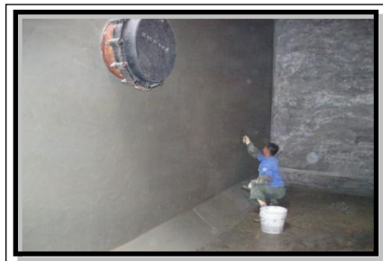
배수지 보수, 보강 후 전경
