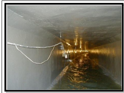
하수암거 보수, 보강 후 전경
