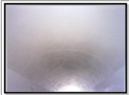
터널 보수, 보강 후 전경
