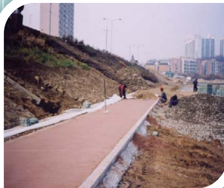
안성시 자전거 도로
